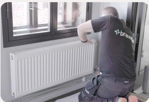
Montering av radiator på Olav Tryggvasons gate 19
