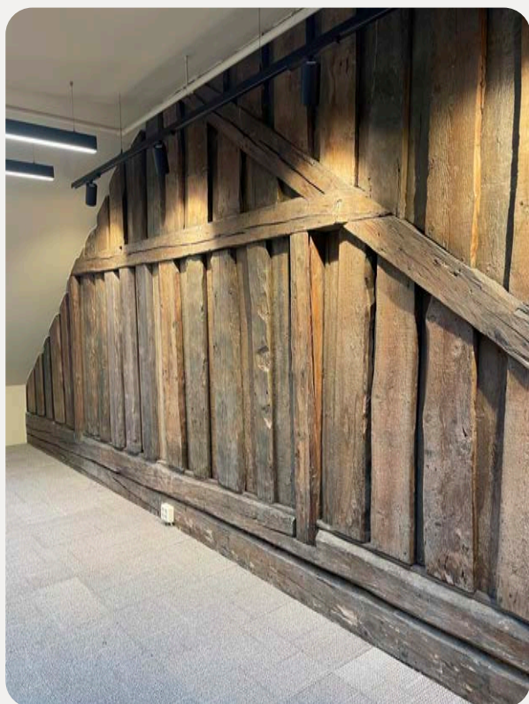
Rengjort og brannlakkert tømmervegg
