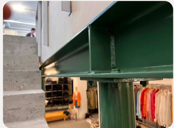
Det er brukt bolter for enklere demontering
