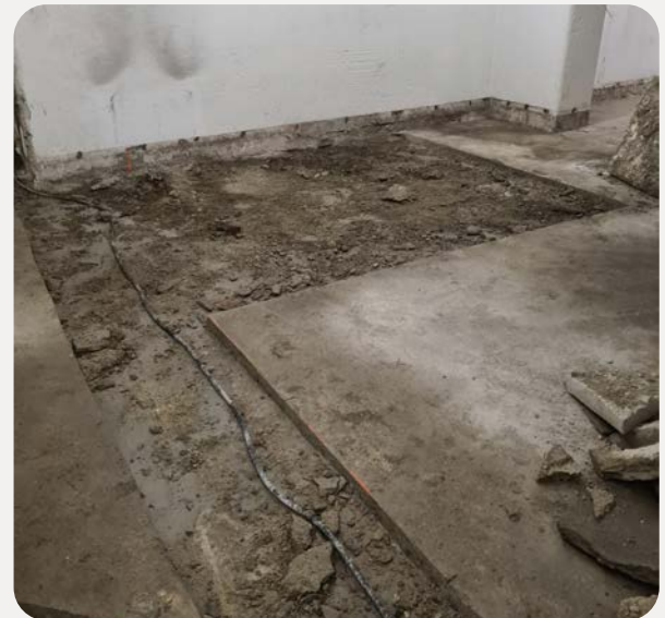
Betonggulvet måtte erstattes
