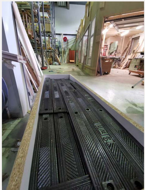
Trappenesene etter behandling
