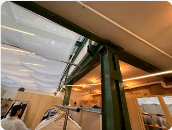
Stålkonstruksjonen er synlig i butikken
