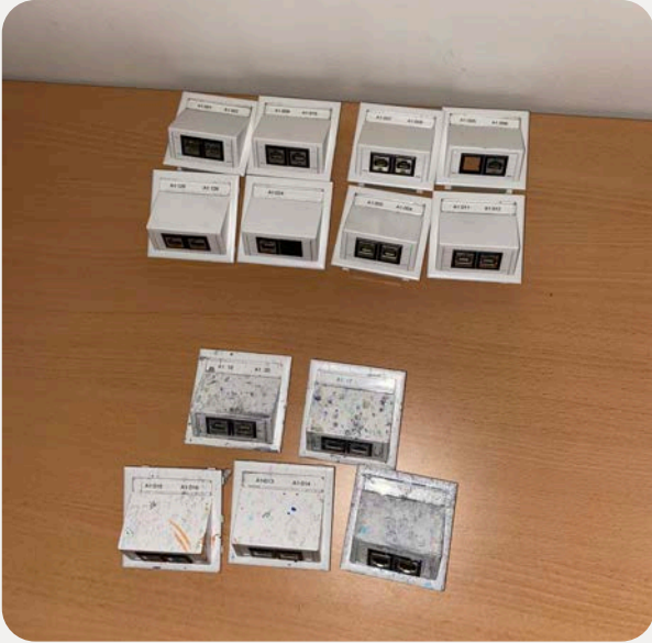
Også her, som på stikkontaktene, måtte vi rengjøre et stort antall kontakter for malingsøl.
