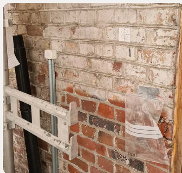
Teglfasade før og etter sandblåsing
