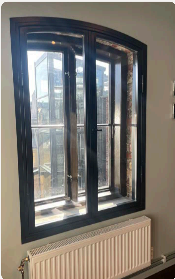
Ferdig renoverte vindu
