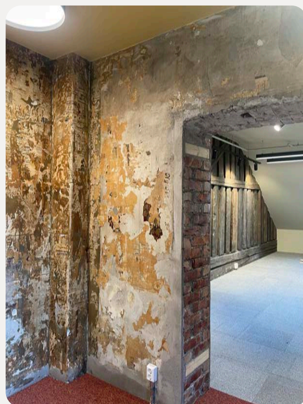
Rengjort og støvbundet mur med gamle aviser
